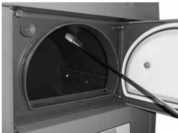
Чищення верхньої завантажувальної камери кочергою
